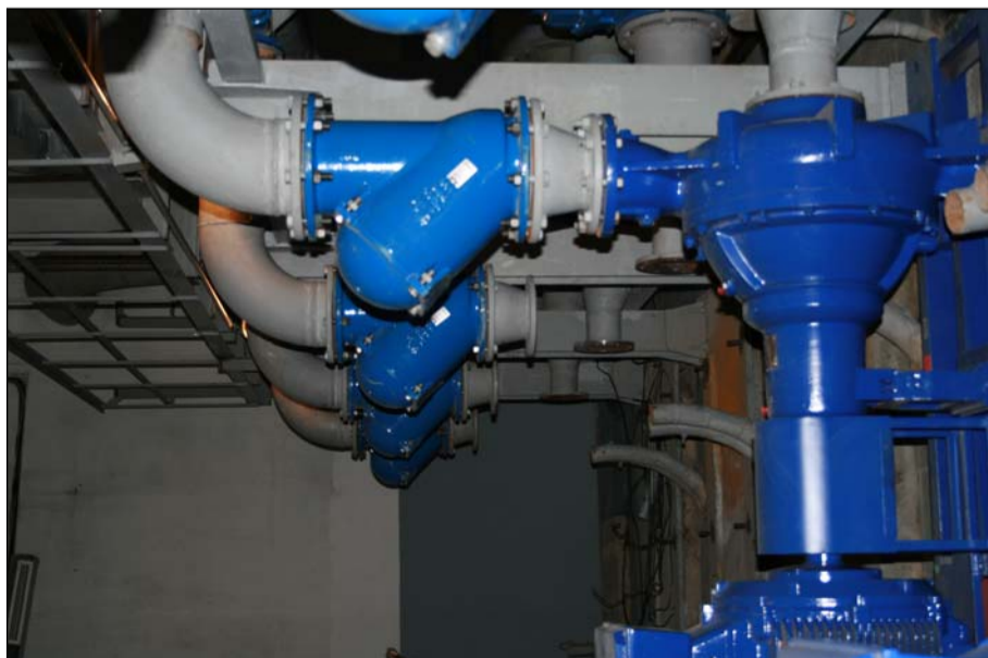
Канализационная наносная станция.
