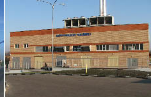
Энергетическая установка «DEUTZ»
