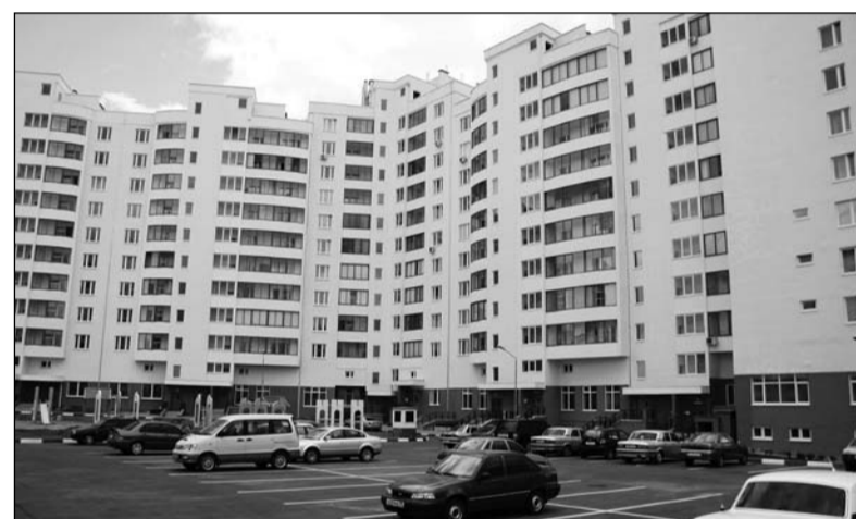
«КМАпроектжилстрой» возводит микрорайоны с полным благоустройством.
