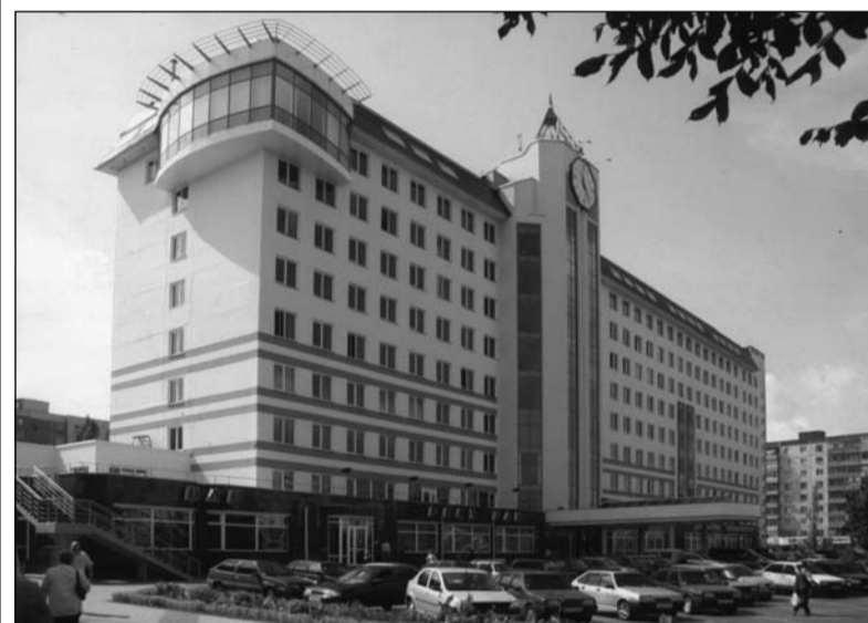
Офисное здание «КМАпроектжилстрой».
